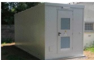
**Le NRO** est un local technique où sont installés les équipements des Fournisseurs d'Accès Internet. Le NRO permet de se raccorder au réseau national et distribuer un signal optique sur une ville ou un village. C'est à partir de cet équipement que sont activés les accès internet des Fournisseurs d'Accès Internet. Var Très Haut Débit va utiliser ou installer plus de 50 NRO sur le département pour raccorder les 119 villes concernées
