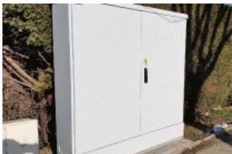
**Le SRO ou PM** est une armoire installée dans la rue. Elle reçoit le signal optique depuis le NRO et permet de le distribuer au sein d'un village, d'un quartier ou d'une rue. Un SRO ou PM permet de distribuer le signal optique auprès de 350 logements environ. Un fois que le SRO ou PM est raccordé au NRO, les partenaires techniques de Var Très Haut Débit construisent progressivement les liaisons optiques à partir ce cet équipement vers chaque logement.
